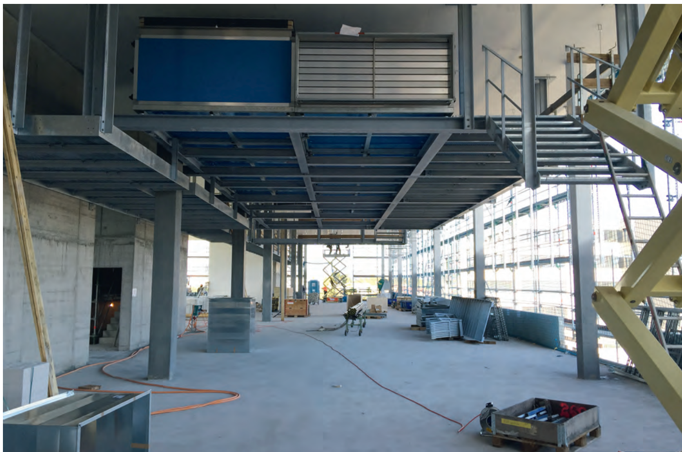
Während im Attikageschoss noch betoniert wird, wurden im 2. Obergeschoss (Produktionsgeschoss) bereits der Catwalk (Gehweg im Zwischengeschoss über der Reinraumdecke) und die Lüftungsanlage für die Zytostatikaherstellung montiert. Die rechts endende Treppe wird später auf die Reinraumdecke führen. (Bild: Meili Bauconsulting AG)
