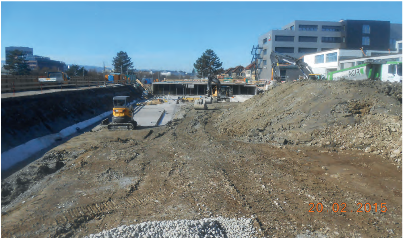
Der Bauplatz nach dem Abbruch, bei Beginn des Aushubs; 20. Februar 2015. (Bild: Meili Bauconsulting AG)
