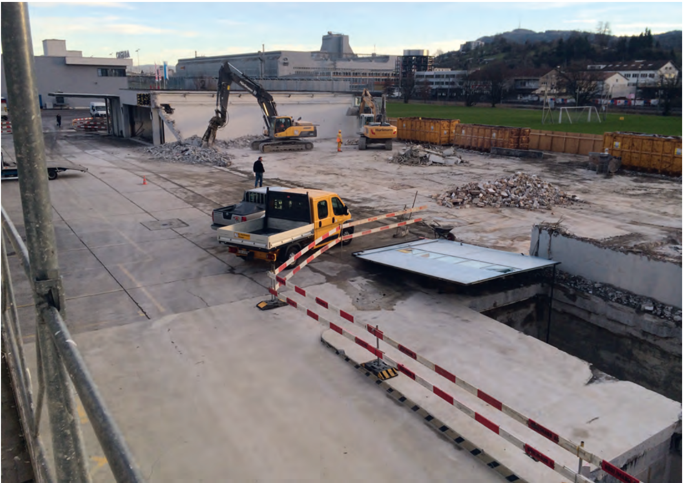
Der Bauplatz bei Beginn des Abbruchs; Januar 2015. (Bild: Meili Bauconsulting AG)
