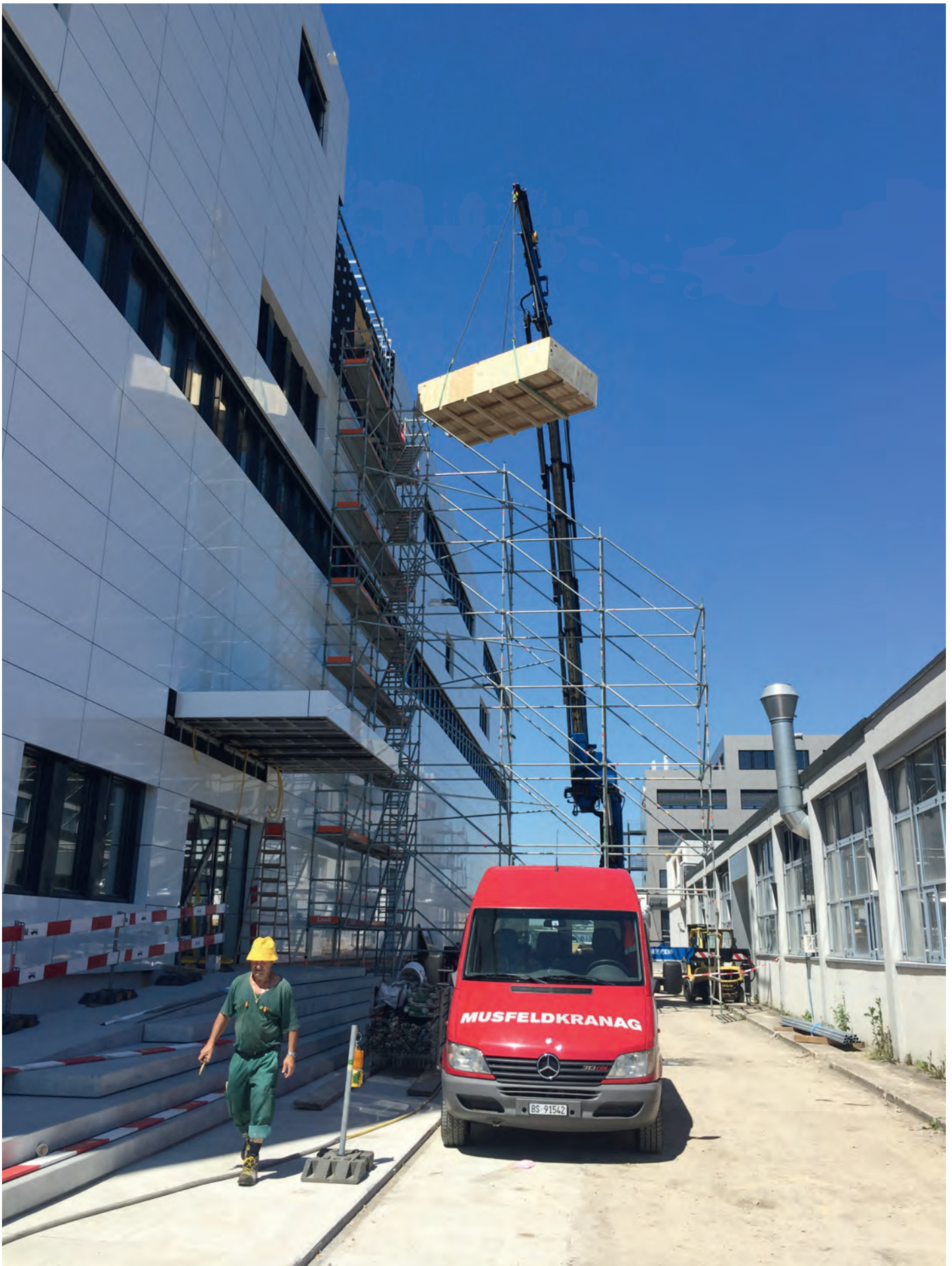
Anlieferung der WFI-Anlage ins 3. Obergeschoss des bald fertig gestellten Baus am 23. Juni 2016. Aus Sicht des Bauablaufs wäre eine Lieferung im Januar 2016 wünschenswert gewesen. (Bild: Meili Bauconsulting AG)
